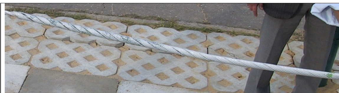
Zdj. 9 – gotowa trójplotowa złączka liniowa
