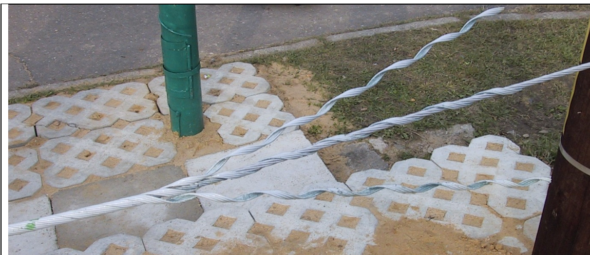
Zdj. 8 – prawa strona odtwarzanej powłoki, pierwszy oplot nawinięty do końca, a dwa następne czekają na oburęczne dokręcenie
