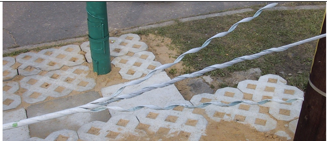
Zdj. 3 – prawa strona odtwarzanej powłoki, pierwszy oplot nawinięty do końca, a dwa następane czekają na oburęczne dokręcenie
